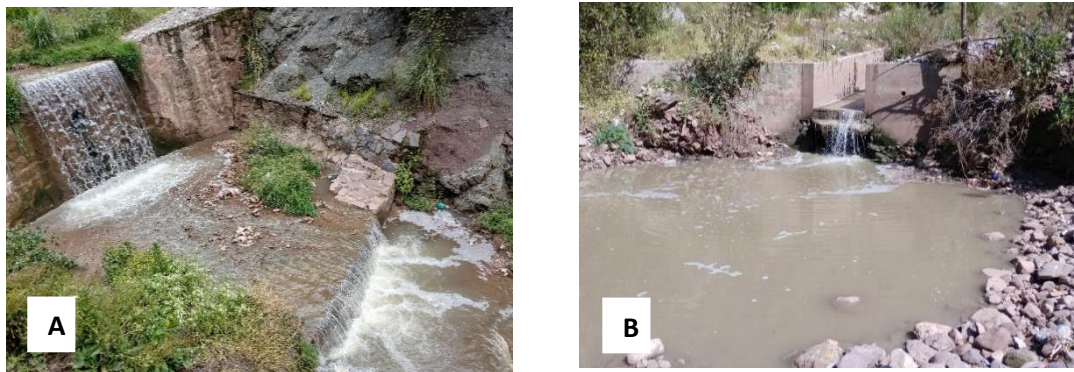
Figura 10. El río Saphy en el último tramo recibe aguas residuales y posee aereadores de cascada que re oxigenan el agua.
